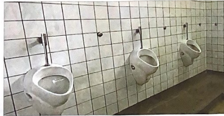
Einige Urinale an der Siegener Gesamtschule sind abgebaut. Früher gab es dort doppelt so viele, wie an den zusätzlichen Wasseranschlüssen an der Wand erkennbar ist.
